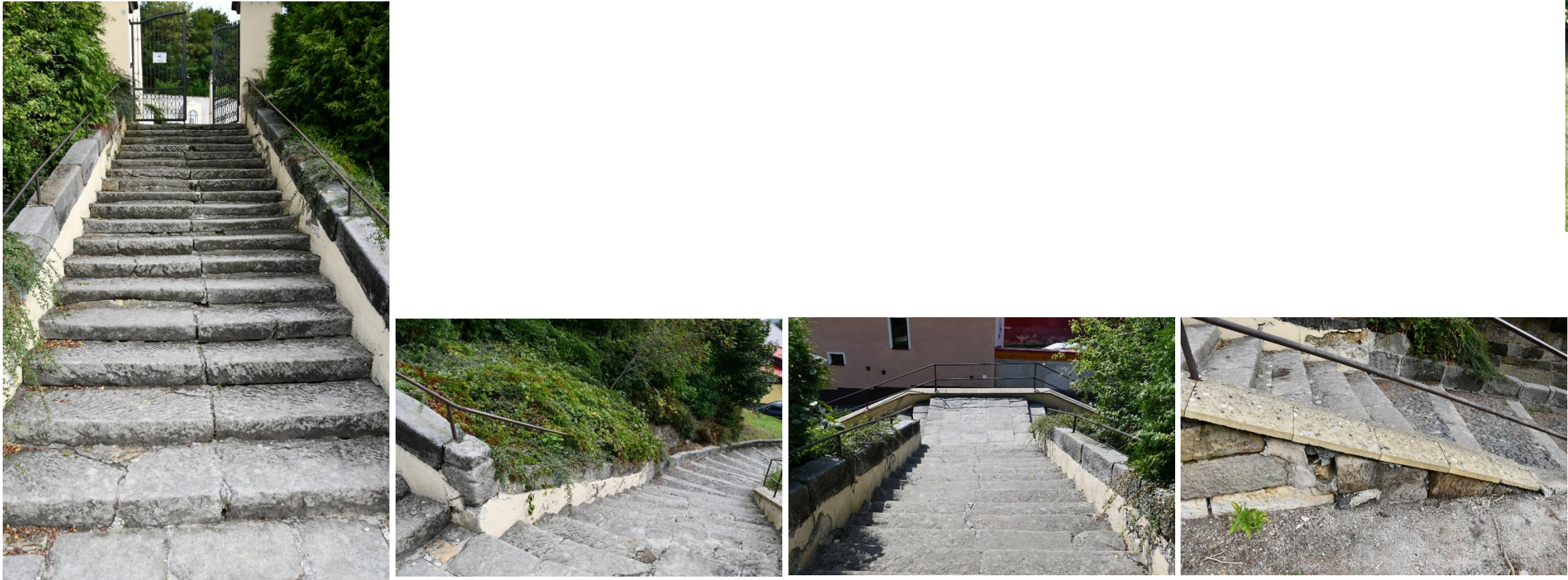
Zídky u schodiště
