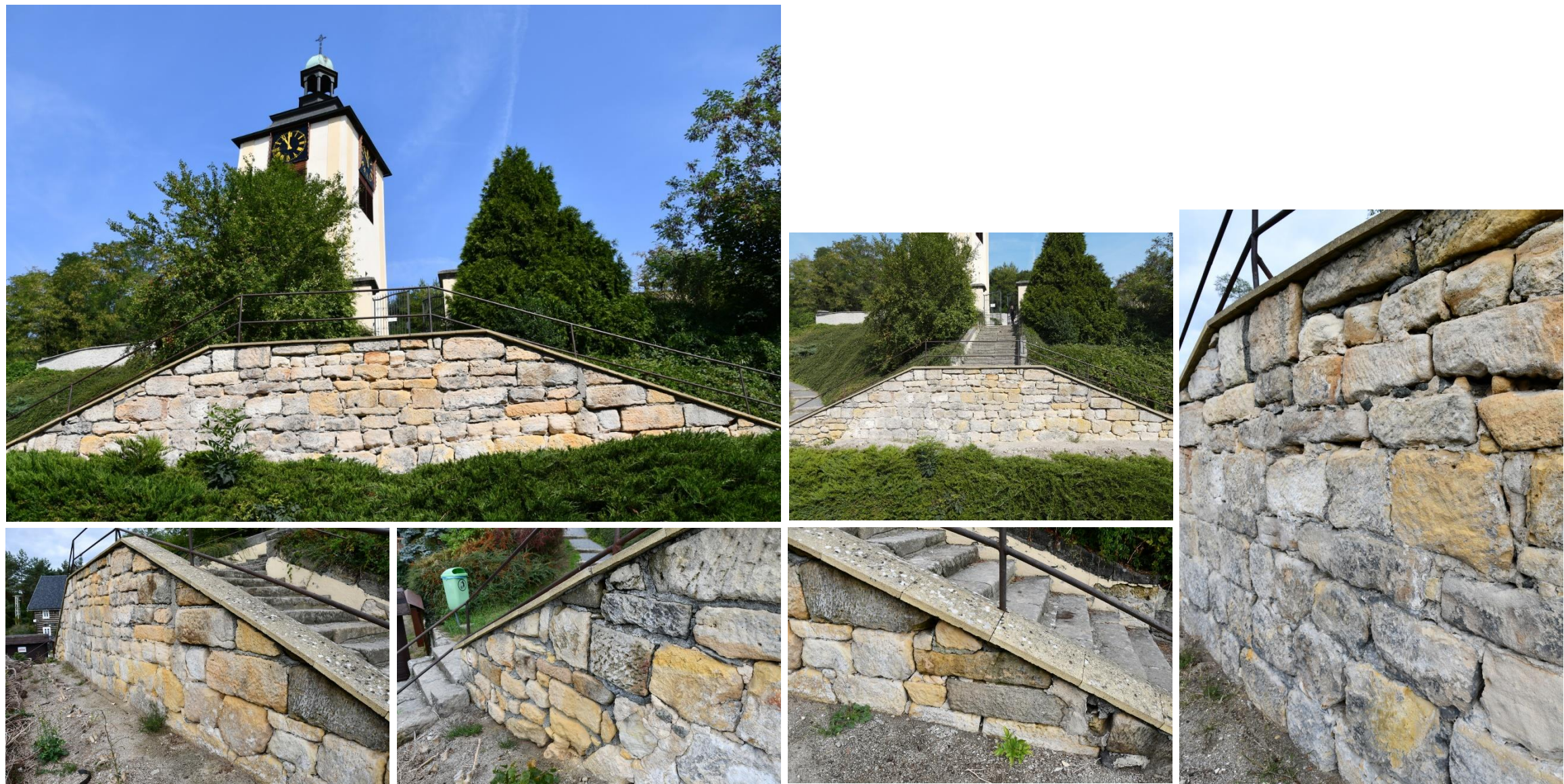
Opěrná zeď u schodiště
